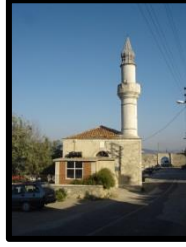
Fotoğraf 39. Rest. öncesi kuzey cephe (BVBM)
