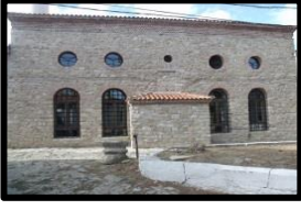
Fotoğraf 49. Rest. sonrası güney cephe (N. Kınca)
