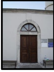
Fotoğraf 31. Rest. sonrası cami giriş kapısı (N. Kınçal)
