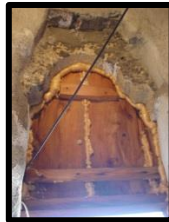
Fotoğraf 44. Minare iç duvarları (BVBM)
