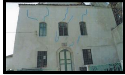
Fotoğraf 22. Rest. Öncesi kuzey cephe (BVBM)
