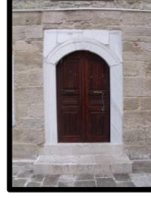
Fotoğraf 5. Cahidi Sultan Hazretleri Camii giriş kapısı (BVBM)
