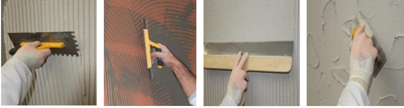
Görsel 12. Capatect Magic Fine (Kaya Doku)' nun uygulanma aşaması
