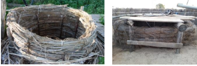
Resim 4 - Etraflıca ağaçla örülmüş kuyunun yukarı kısmı
