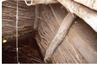
Resim 6 - Hazır duvarlı ağaç kuyusu
