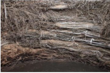
Resim 2 - Ağaç dallarıyla kapatılmış duvarlar
