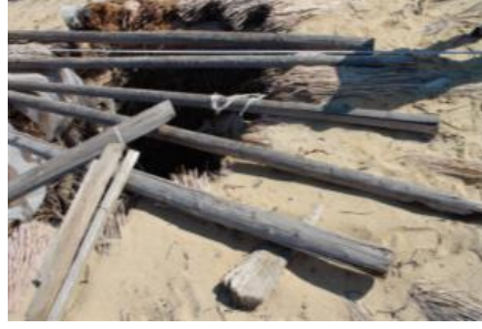
Resim 14 - Duvarı düzgen ağacı, üzeri kamışla kaplanmış şekli
