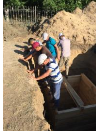
Resim 9 - Ağaç duvarlarını bastırarak dikmek yöntemi
