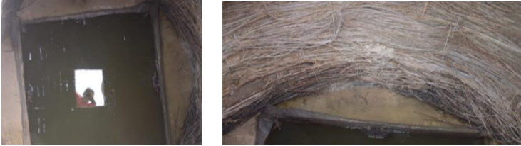
Resim 5 - İki katlı ağaç kuyusunun iç görünüşü
