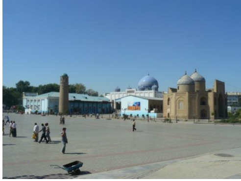
Resim 11: Şeyh Muslihiddin Türbesi, Pendşembe meydanından genel görünüşü (Sağ kenardaki yapı)
