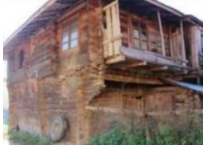
Resim 2. Ahşap Yığma Tekniği, Bartın (Uzun, 2019: 680)
