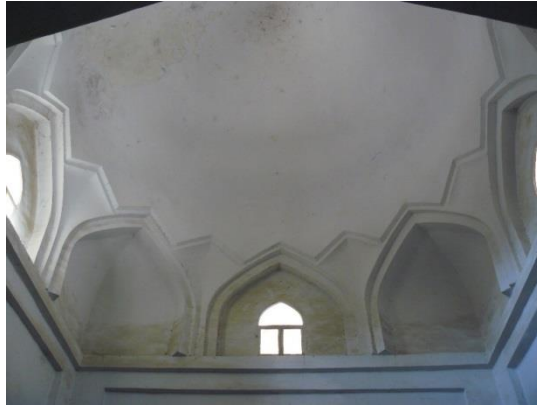
Resim 44: Mir Recep Dodko Medresesi, giriş eyvanın batısındaki mekanın üst örtüye geçişleri
