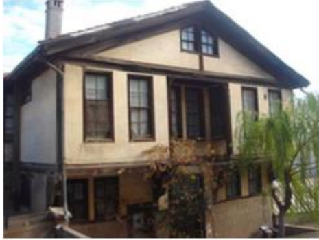
Resim 5. Çatı Arası Katı Örneği, Kastamonu
