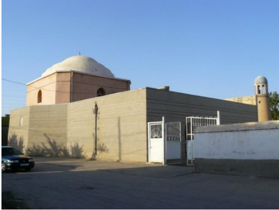
Resim 2: Abdullah Han Camisi, güneydoğu yönden görünüşü
